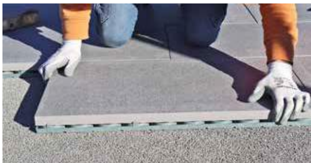
POSTAVLJANJE EASY PAVING METODOM
